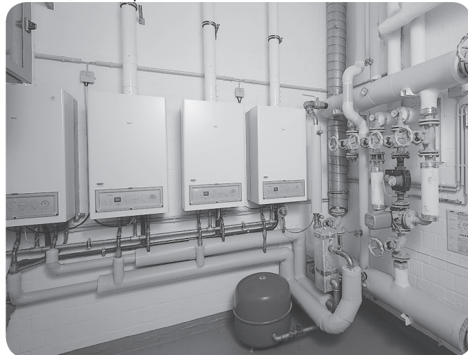
Нагревательные котлы, каскадное подключение
