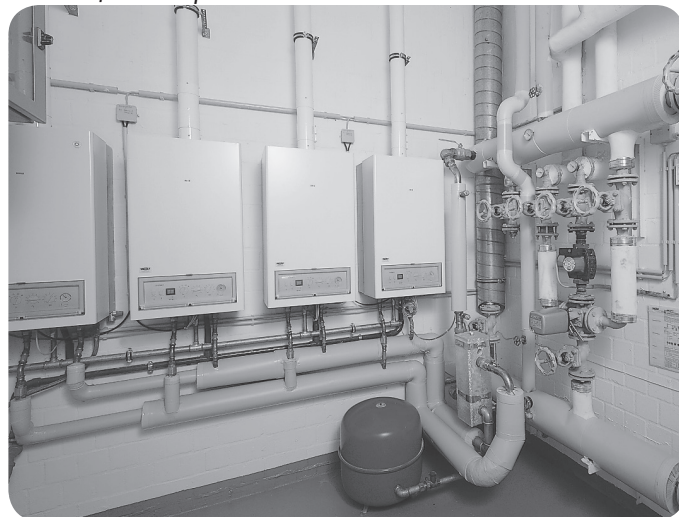
Нагревательные котлы, каскадное подключение
